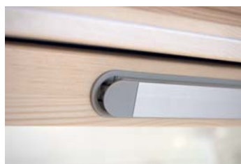
ventilační klapka dřevěného okna
