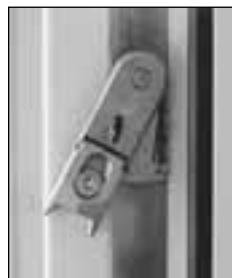
pojistka proti otáčení kliky
